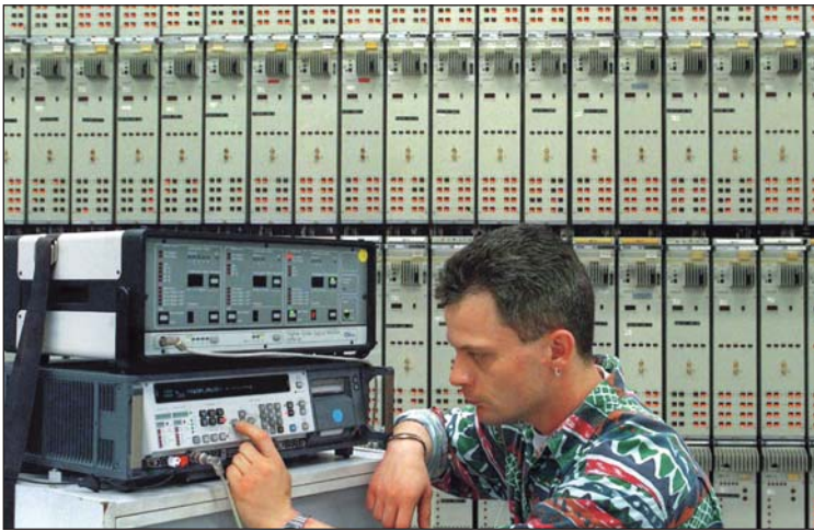
Central de conmutación digital. Los aparatos del fondo son los encargados de establecer y encaminar las llamadas.
